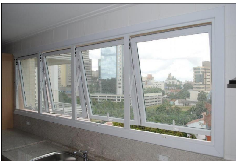
Figura 08 – Exemplo de janela tipo maxim-ar em alumínio branco.
